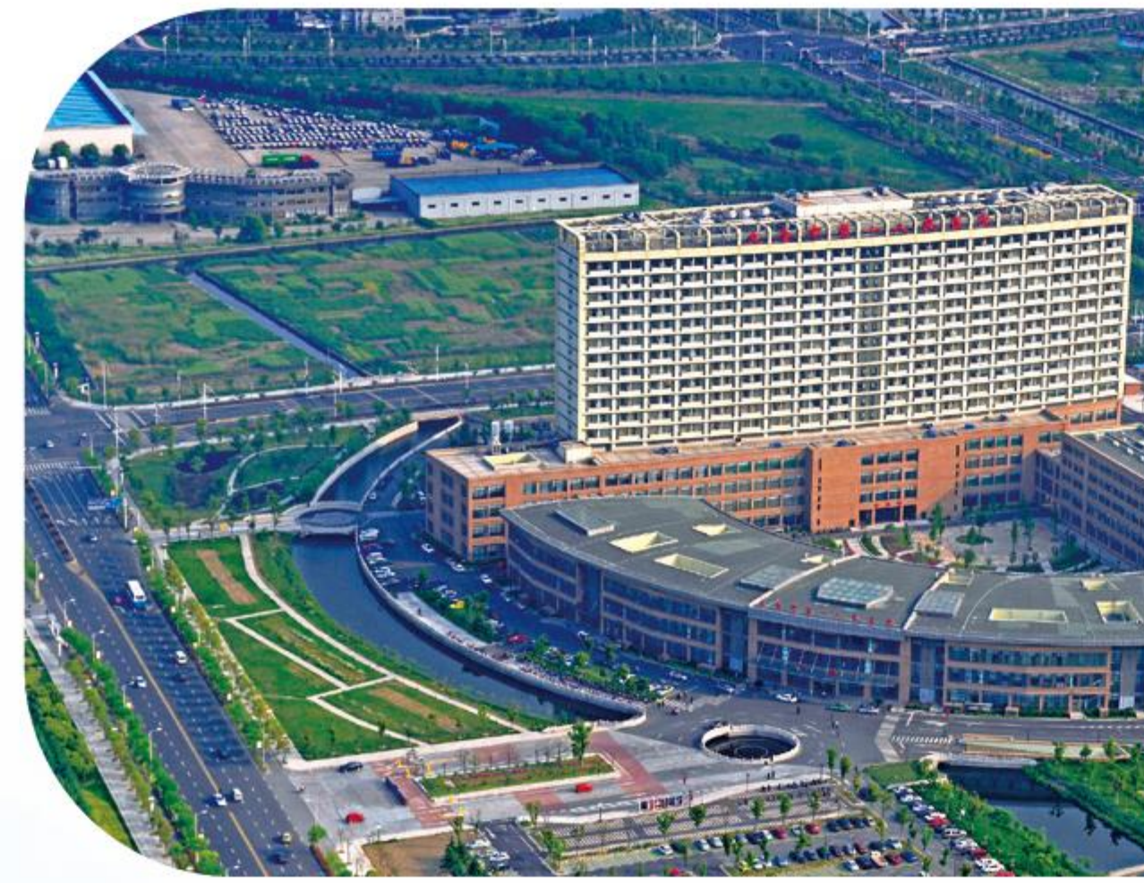
太仓市第一人民医院 Taicang First People's Hospital
