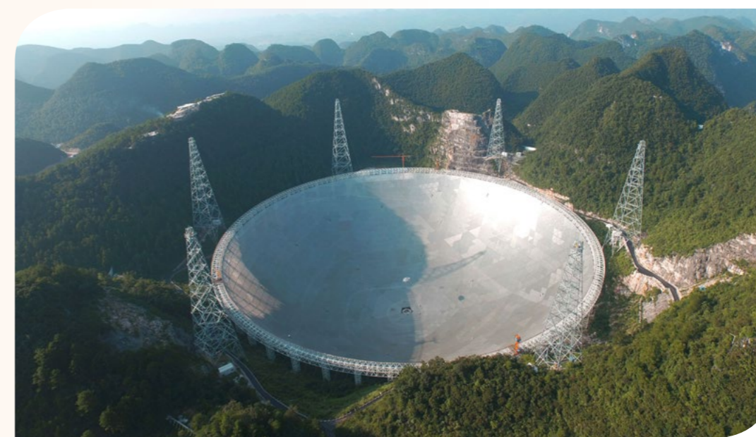
500米口径球面射电望远镜（FAST）项目主体工程
